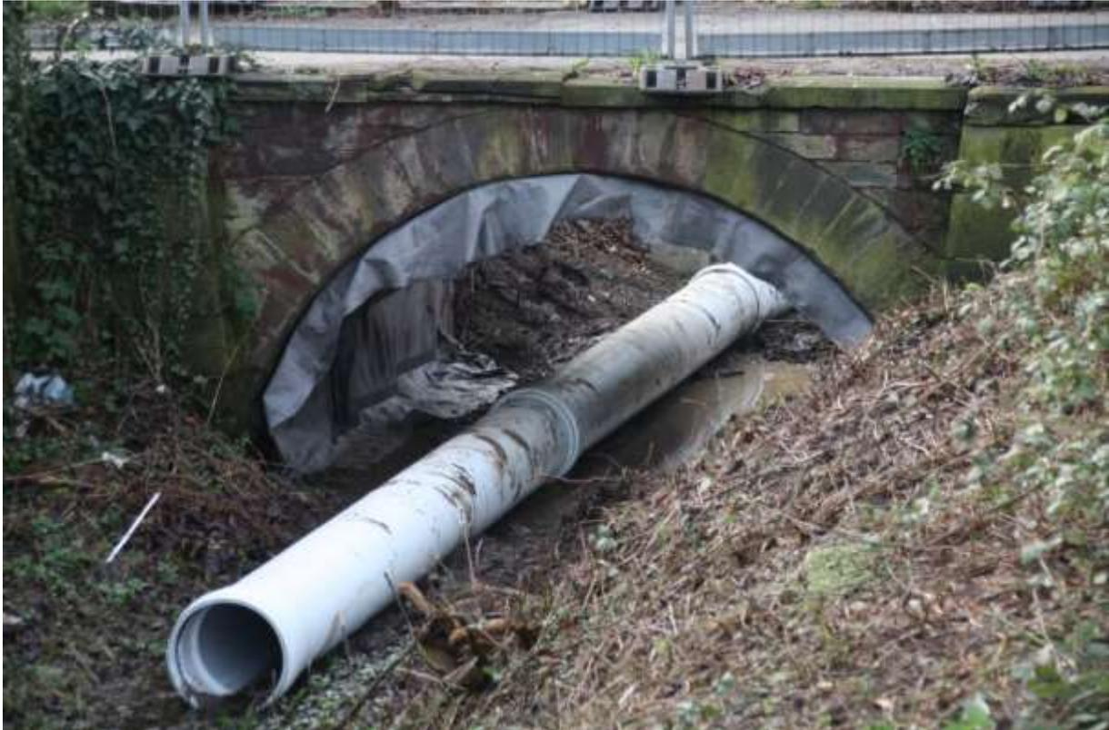
Bretterschalung angebracht und das Loch zum Befüllen mit Flüssigboden gebohrt.
